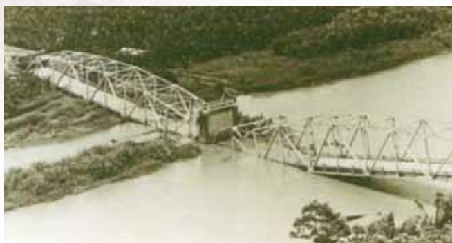
Imagen No. 3. Colapso del Puente sobre Río La Estrella producto del Terremoto de Limón, 1991.
