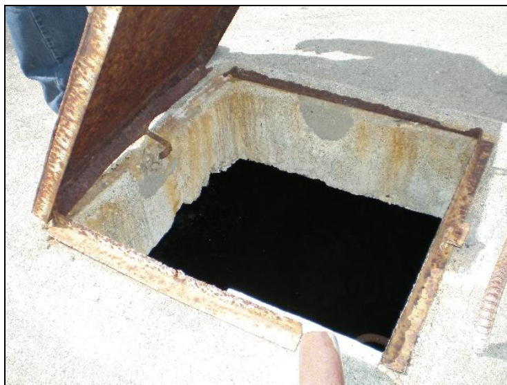
Figura 2.5. Tanque Sardinal: tapa de acceso.
