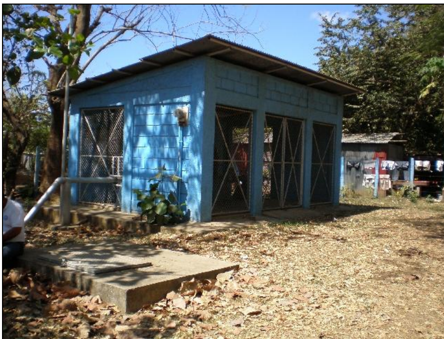
Figura 2.1. Caseta del Pozo #1 de Sardinal.
