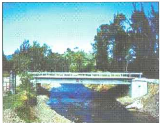
Puente sobre el Rio Purires, El Guarco, Cartago.
