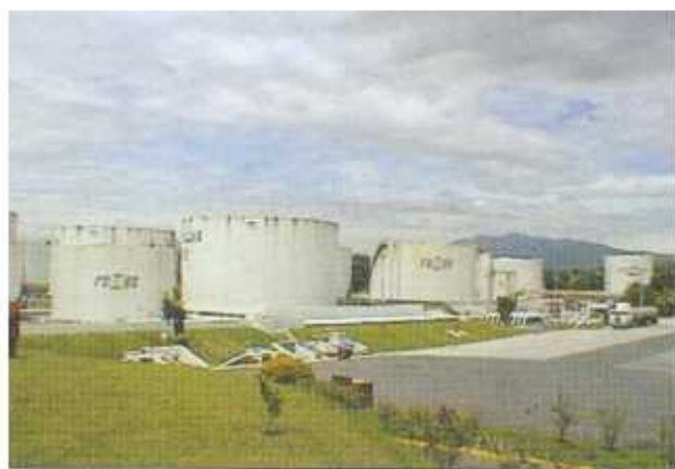
Plantel de Almacenamiento de Combustible - Recope
