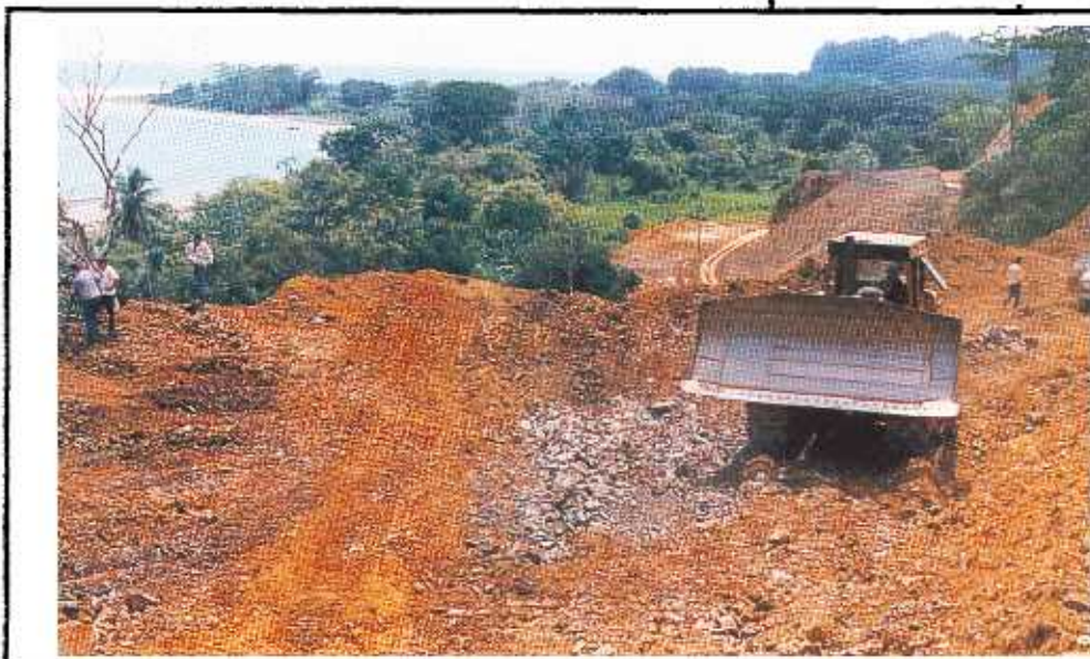
■ La construcción de la carretera Barú-Pituzela, en la Zona Sur del país, ha sido uno de los proyectos de contingencia social administrados por la CNE.
