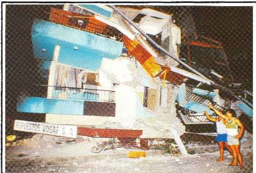
La infraestructura turística resultó severamente dañada por el sismo, como se observa en esta fotografía del Hotel Internacional, el cual estaba ubicado en el centro de Limón.
