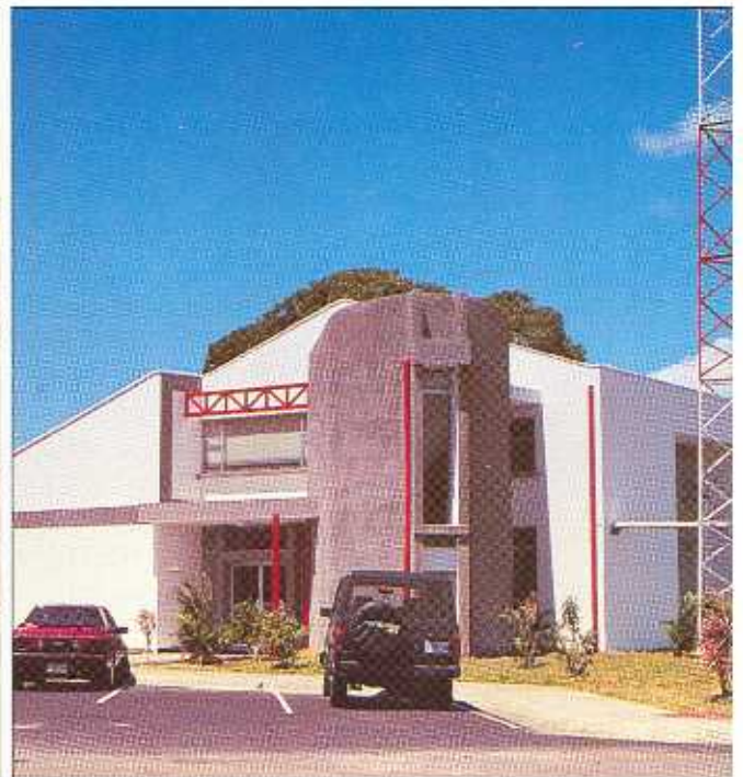
Edificio de la Central Única de Alarmas 9-1-1 en las instalaciones de la Comisión Nacional de Emergencia, Páiz
