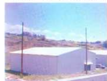
Bodegas de la CNE, las cuales se utilizan para el almacenamiento de material para casos de emergencia y para la flota de vehículos.
