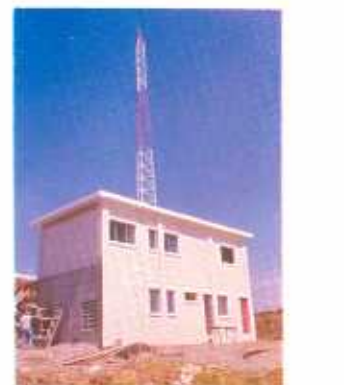
Edificio de Comunicaciones de la CNE.
